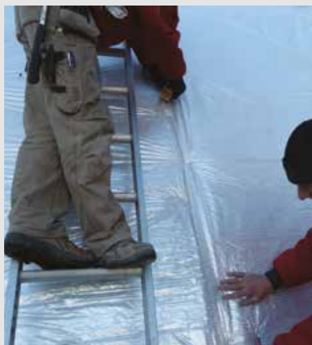
Banen onderling vastzetten met tape
