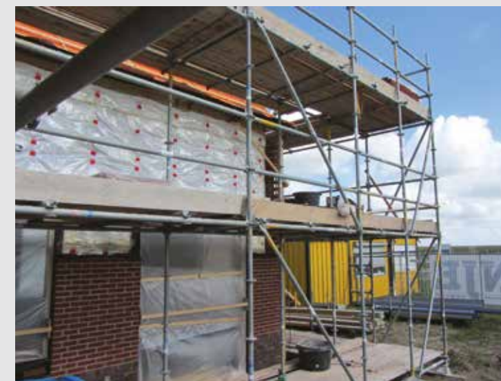
Spouwisolatie bij nieuwbouwwoningen
